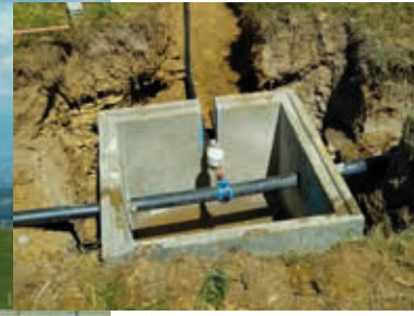
▲ Installation de la colonne de distribution d'eau avec regards de visite
