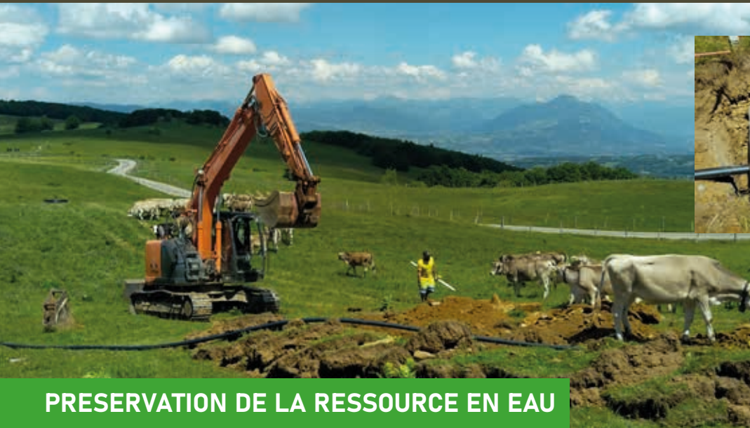
▲ Installation de la colonne de distribution d'eau avec regards de visite
